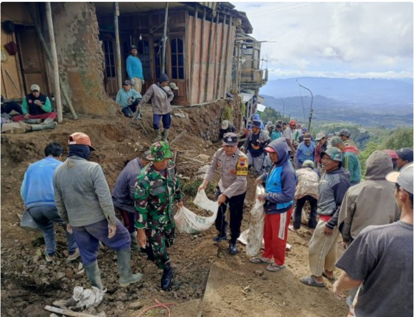
(Foto Dokumen) : Gotong royong pembersihan material longsor
